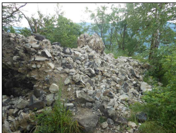
Hrad Himlštejn, destrukce věže (foto P. Mašek 2021).
