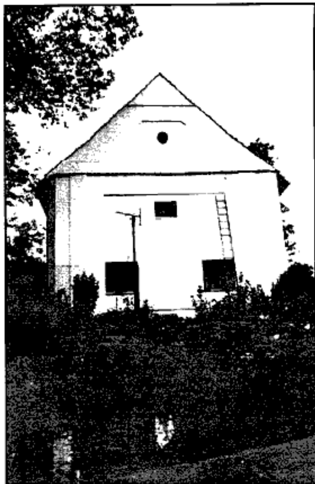
Obr. 4: Úloh, kostel svatého Petra a Pavla, pohled na jihozápadní průčelí
