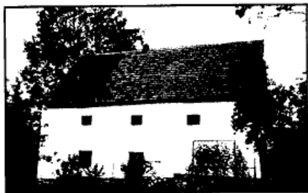
Obr. 5: Úloh, kostel svatého Petra a Pavla, jihovýchodní průčelí
