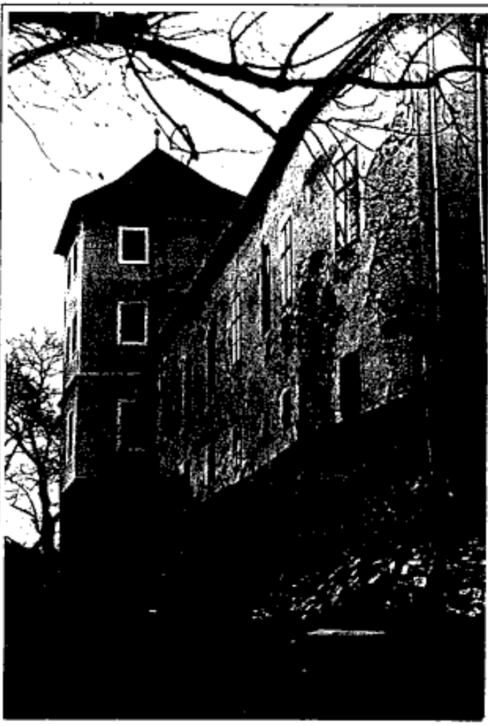
Horažďovice. Vystupující zdivo věže západního křídla zámku. Nad vrcholem soklového zdiva dvě střílnová okénka.
