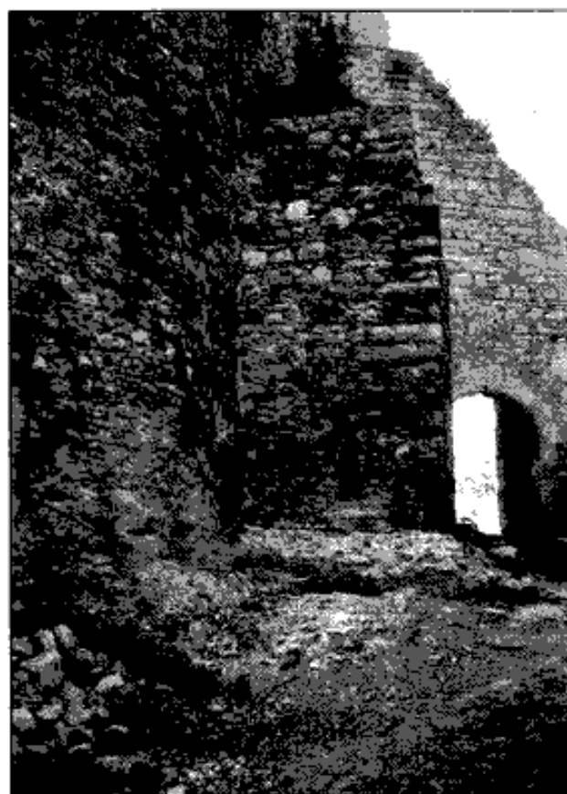
Hrad Boskovice (okr. Blansko). Zkoumaný prostor pod východním obvodem hradního jádra po odstranění suti. Vzadu průjezdný pozdně gotický pilř s portálem završeným oslřm obloukem, uprostřed jižní zeď gotickorenesanční věžice, vlevo východní hradba jádra s relikty dosud neznámých konstrukcí (foto J. Štětina 2005)
