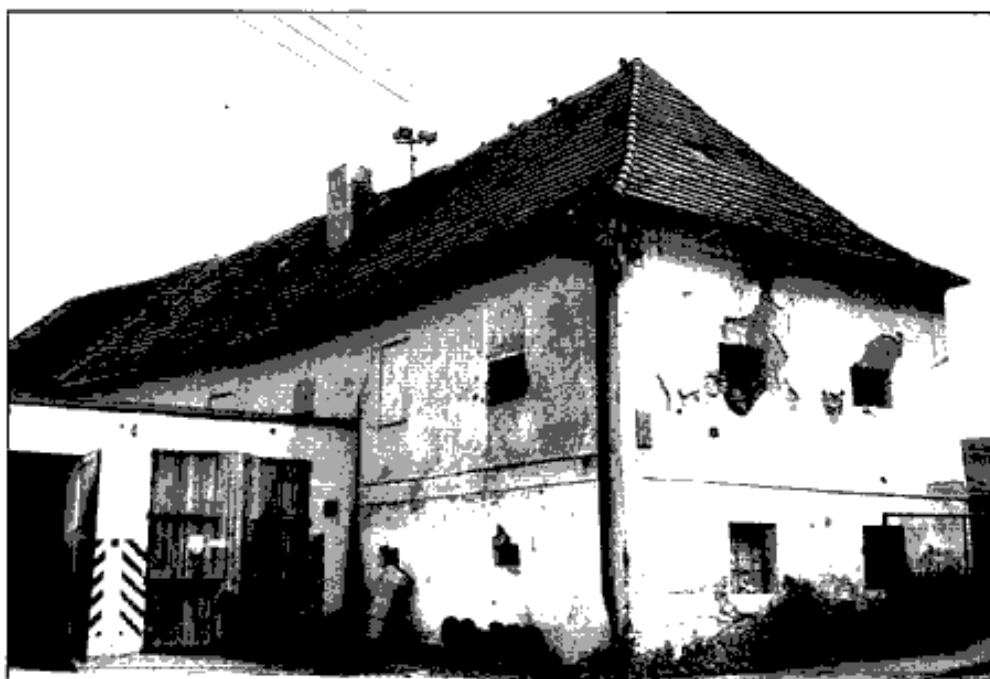
Malinec, část západního a jižního průčelí bývalého zámku. Stav v srpnu 1989 (foto autor)
