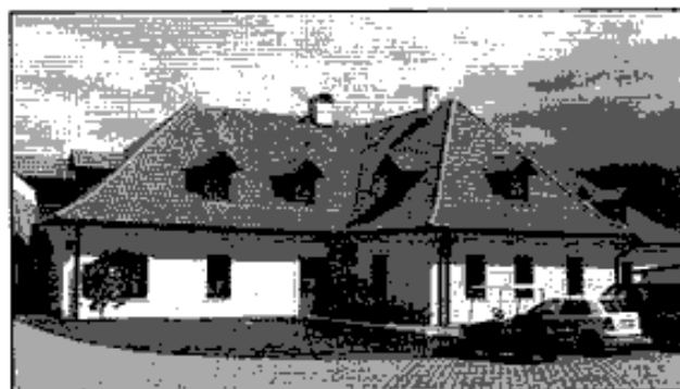
Předpokládaný objekt bývalého zámku v Darové. Levá část stavby při vjezdu do dvora a křídlo vystupující do nádvoří půdorysně souhlasí s půdorysem zámku na mapě stabilního katastru (foto V. Chmelíř 2006)
