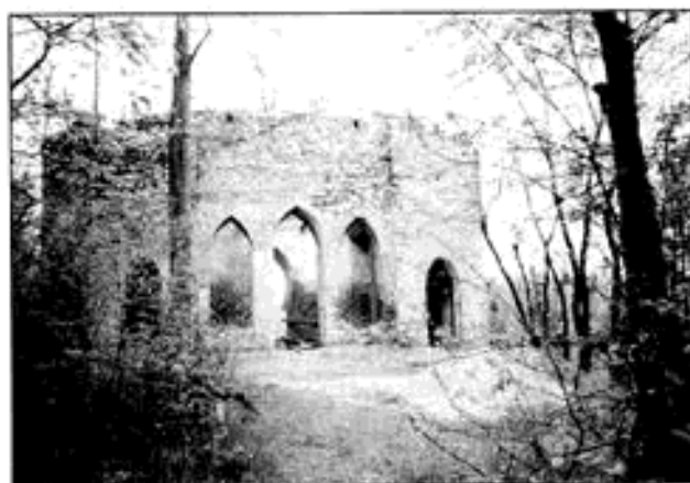
Hrad Březina, květen 2001. Severozápadní stěna pavilonu. Část průčelí je nově vyzděna. Oba snímky A. Noháčová
