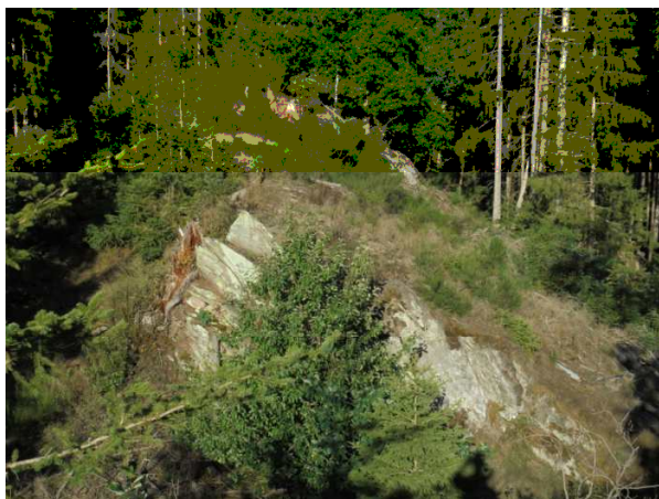
Obr. 9: Údolí Hadovky, vylámaný příkop přepadu vody východního rybníka (foto autor 2023).
