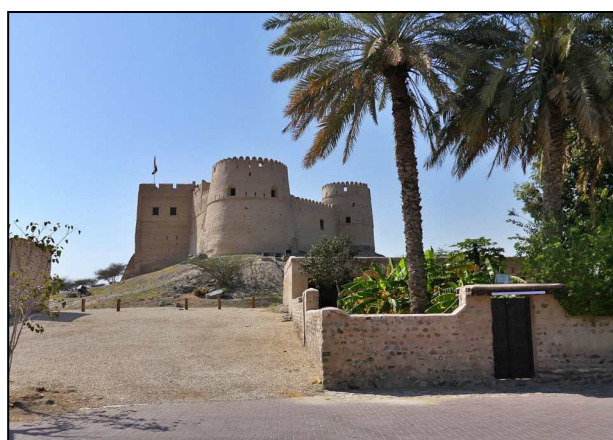
Fujairah Fort, pohled od staré mešity (foto P. Špráchal).
