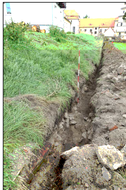
Obr. 4: Středověké zdivo o tloušťce 1,1 m v severním výkopu na dně. Pohled od západu (foto autor).
