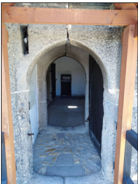
Obr. 8: Vstup do obytné věže v úrovni prvního patra.
