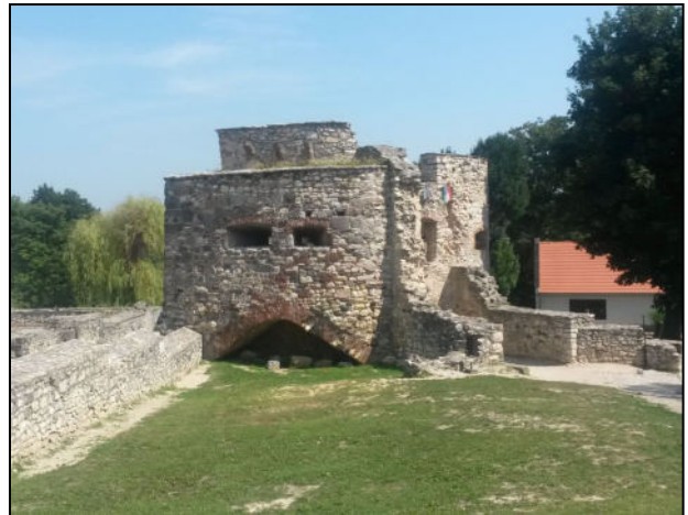
Obr. 21: Pohled na barbakán od místa přístupové cesty
