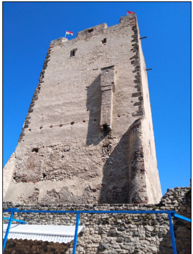
Obr. 12: Pohled na jižní stěnu obytné věže s přízděným kanalizačním svodem.
