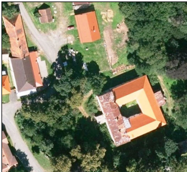
Zámek Kanice a objekty dvora na leteckém snímku z roku 2016. Střechy na třech křídlech zámku jsou opravené ( https://mapy.cz ).
