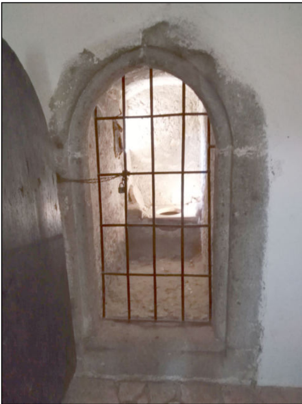
Obr. 11: Prevét v druhém patře obytné věže.
