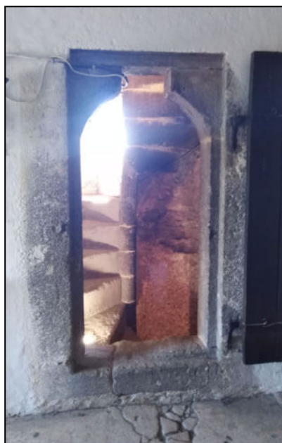
Obr. 9: Vstupní portál k vřetenovému schodišti v síle obvodové zdi.
