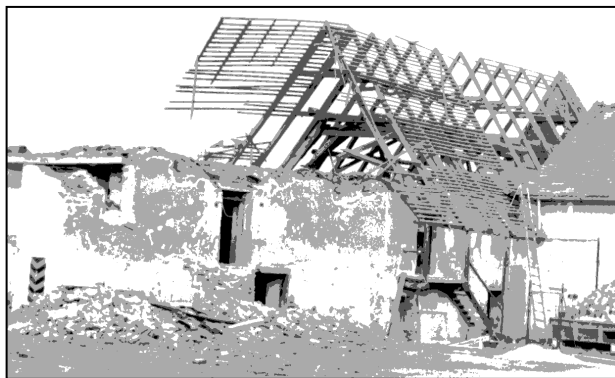
Obr. 9: Mířkov, pohled na bořený objekt ze dvora (foto 1983).
