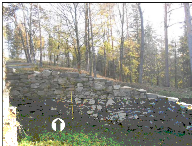
Obr. 3: Zřícenina hradu Bukov (Lísek). Pohled od severozápadu na vnitřní líc obvodové hradby západně navazující na těleso bergfritu (foto autor 2020). Šipka označuje pozici technologické západnější spáry.
