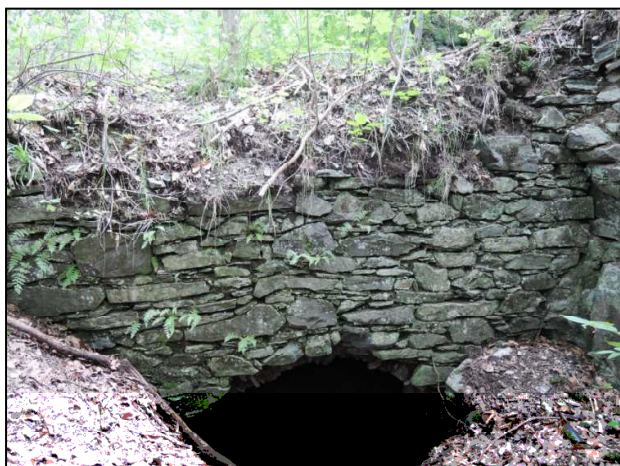
Obr. 5: Hrad Louka – detail dělicí zdi mezi suterény č. 01 a 02 severní budovy od západu (foto autor 2016).
