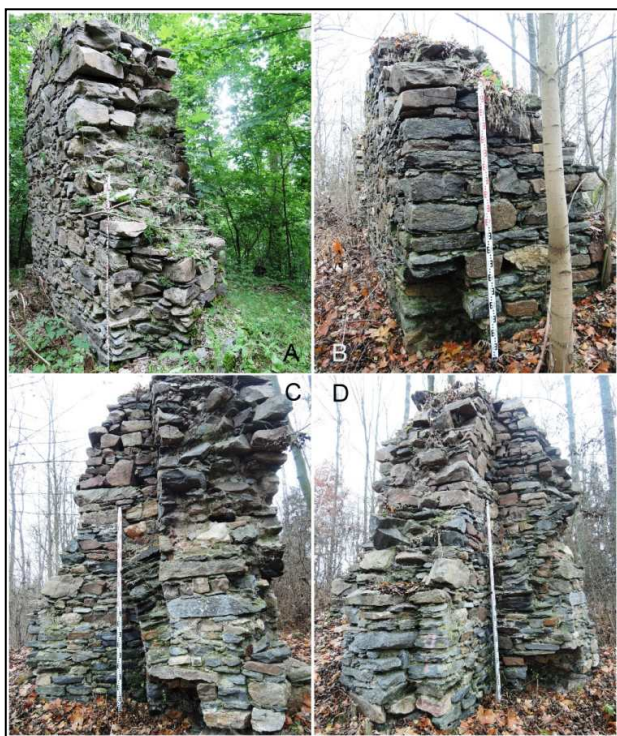
Obr. 8: Hrad Louka – pozůstatky jižní budovy: A – část nádvoří zdi s ozubem po ostění prostory č. 01 (od severozápadu); B – severozápadní nároží jižní budovy s pravděpodobně vytrženým nákolníkem, napravo málo zřetelné pozůstatky okna směřujícího k bráně hradu; C – výběh klenby v prostoru č. 02 (od východu) a dělicí zeď s prostorou č. 01; D – dělicí zeď mezi prostorou č. 01 a č. 02 se špaletou průchodu a ozubem po ostění, napravo výběh klenby prostory č. 02 (foto autor 2016).
