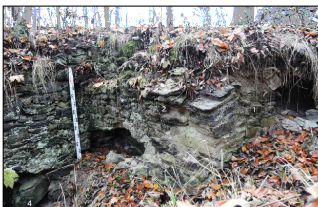
Obr. 6: Hrad Louka – přízemí středního dílu severní budovy, jihovýchodní kout se špaletou nádvorního vstupu (od severozápadu): 1 – špaleta vstupu z nádvoří s výběhem klenby; 2 – zbytky valené klenby přízemí; 3 – východní zeď středního dílu přízemí; 4 – místo zřícené klenby suterénu č. 01 (foto autor 2016).
