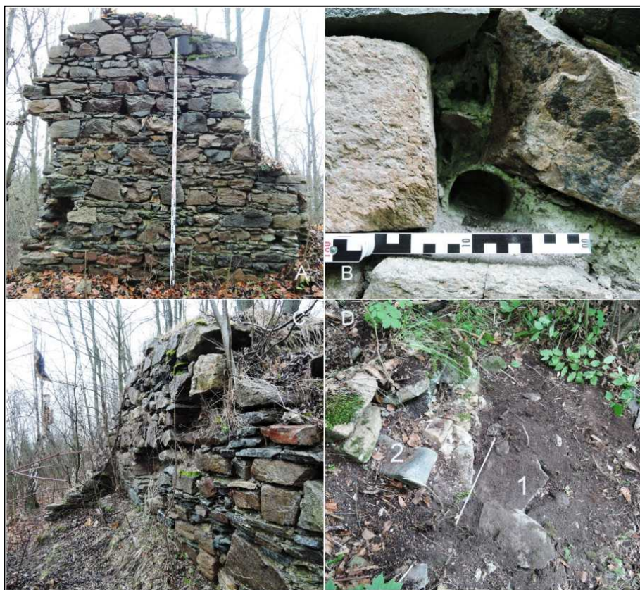
Obr. 9: Hrad Louka – detaily jižní budovy jádra hradu: A – dochovaný vnější líc nádvoří zdi jižní stavby (od severu); B – detail kruhové lešeňové kapsy v nádvoří zdi; C – interiér prostory č. 01 od východu, vpravo nádvoří zeď s patrnou „lavičí“ při zemi, vlevo výběh západního čela budovy s nepatrnými pozůstatky okna směřujícího k bráně; D – detail styku jižní budovy (č. 2) a obvodové hradby (č. 1) v příkrém jižním svahu pod jádrem hradu. Bílou linkou je naznačena spára mezi oběma konstrukcemi, pohled od západu (foto autor 2016).
