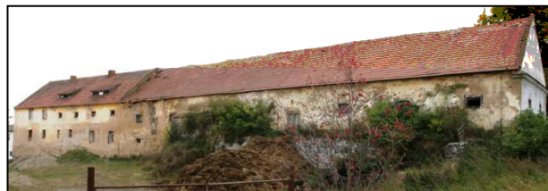
Dvůr Žitín, severovýchodní křídlo s patrovou obytnou částí (foto P. Vařeka 2009).
