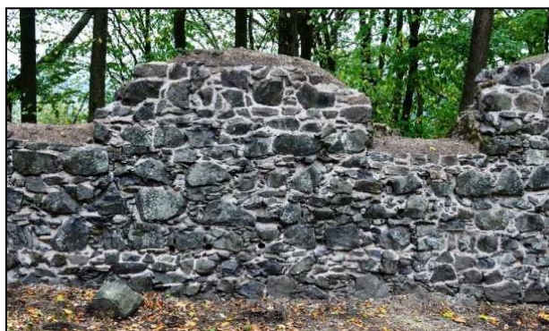
Opravená část úseku vnějšího opevnění na hradě Kumburk u první brány (foto T. Šimůnek 2018).
