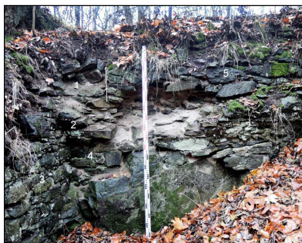
Obr. 4: Hrad Louka – prostora 02 v přízemí severní stavby (pohled od severu): 1 – zazděné okénko (?) v nádvorní zdi; 2 – výběh mladší klenby; 3 – zeď mezi touto místností a sklepem (č. 01); 4 – zdivo pod klenbou nasedající na upravený skalní útvar; 5 – hrubě lícované zdivo nad klenbou (foto autor 2016).
