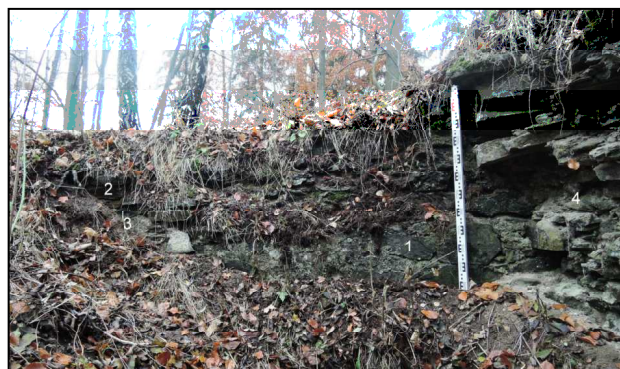
Obr. 7: Hrad Louka – severní zeď středního dílu přízemí (od jihu): 1 – svislé zdivo pod klenbou, patrně svázané s obvodovou hradbou; 2 – zbytky výběhu valené klenby; 3 – drobný ústupek ve zdivu snad určený k položení podlahových fošen; 4 – východní zeď středního dílu přízemí (foto autor 2016).
