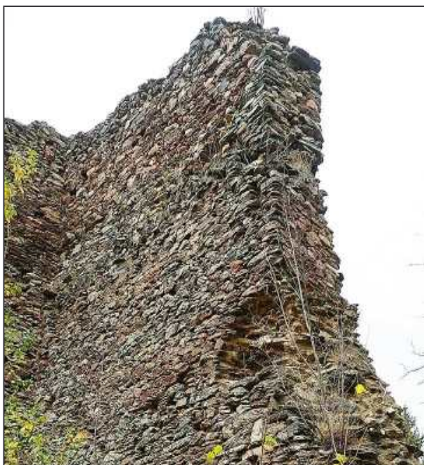
Pajrek (okr. Klatovy), donjon, severní zed' se špaletami z interiéru.
