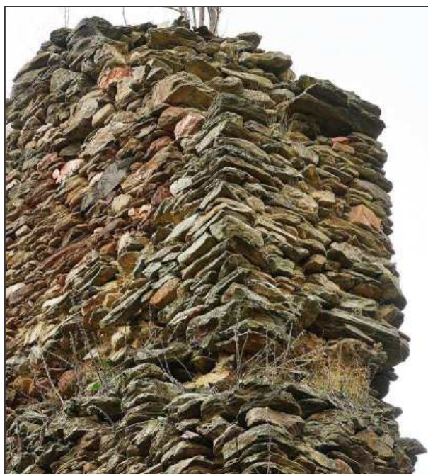
Pajrek (okr. Klatovy), donjon, severní zed', detail špalety 4. podlaží.
